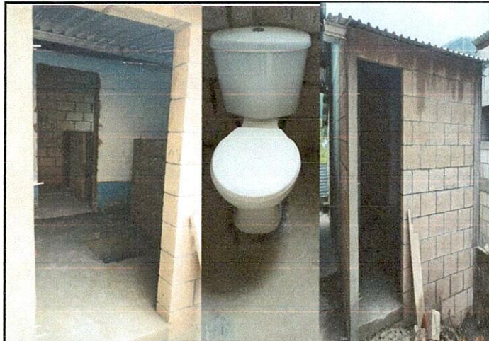
Foto 2: Mejoramiento de servicios sanitarios
